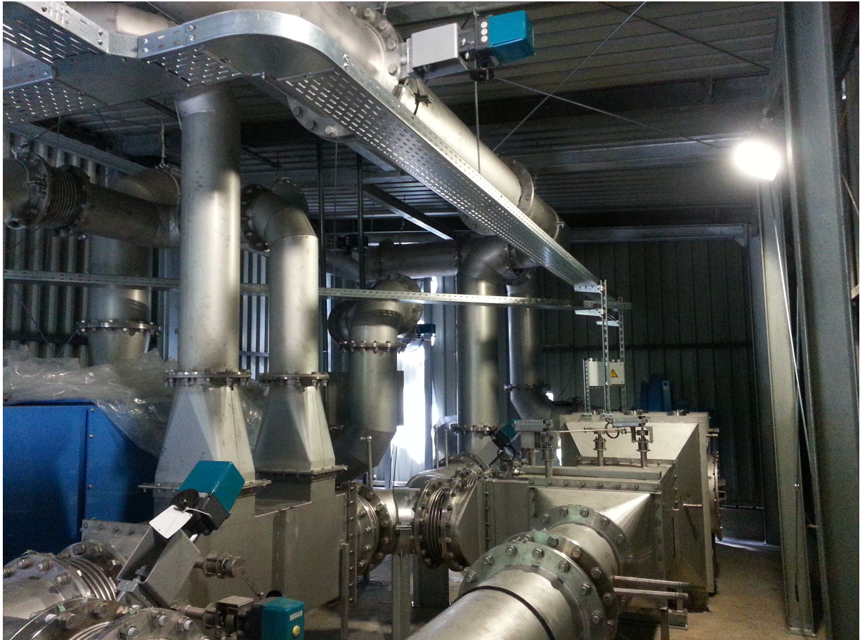
Bild 12: Abbau von Xylenen, Acetaten und Alkoholen in der Rüstungsindustrie, 6.000m 3 /h, Deutschland
