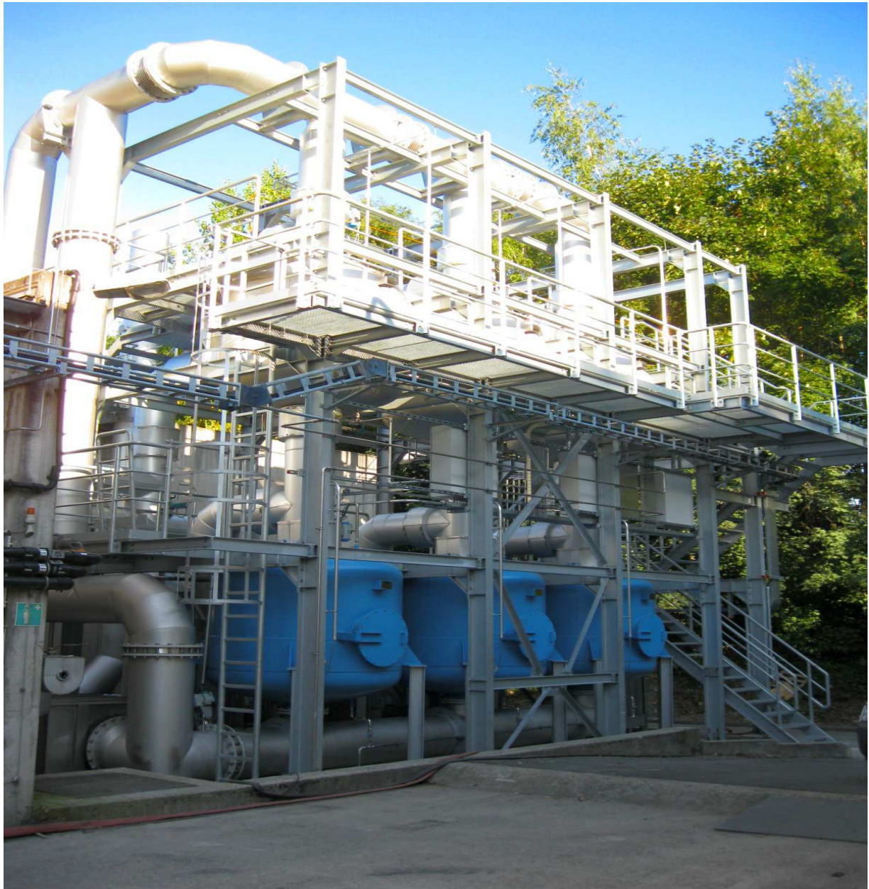
Bild 11: Abluftreinigung bzgl. BTEX-Aromaten und Alkylbenzolen in der Chemieindustrie, 14.000 m³/h, Deutschland
