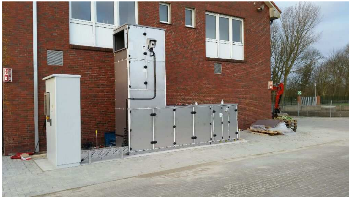
Bild 9: Absaugung Rechenanlagen und gekapselte Klärbecken auf Kläranlage, 6.000m 3 /h, Deutschland
