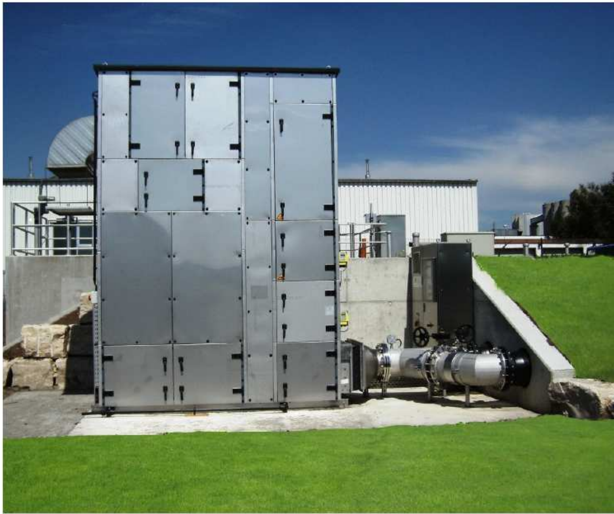
Bild 8: Abwasserkanalbewetterung bis 3.000m 3 /h, Deutschland
