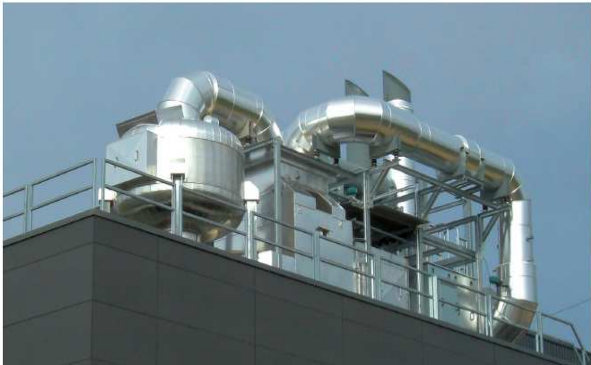
Bild 1: Ethanolabbau bei Lohnfertigung von Medikamenten, bis 18.000m 3 /h, Schweiz
