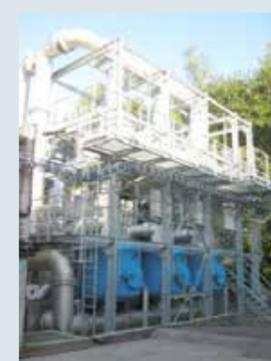
02 Abluftreinigung bezüglich BTEX-Aromaten und Alkylbenzolen in der Chemieindustrie (14 000 m<sup>3</sup>/h)
